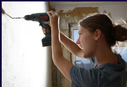
Gat in de muur
